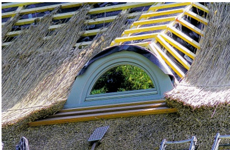
Reetdachsanierung bei Volker Todt in Schwabstedt. Auch Fenster und Türen wurden erneuert. Das Wohnhaus wurde 1850 erbaut. Foto: Volker Todt
