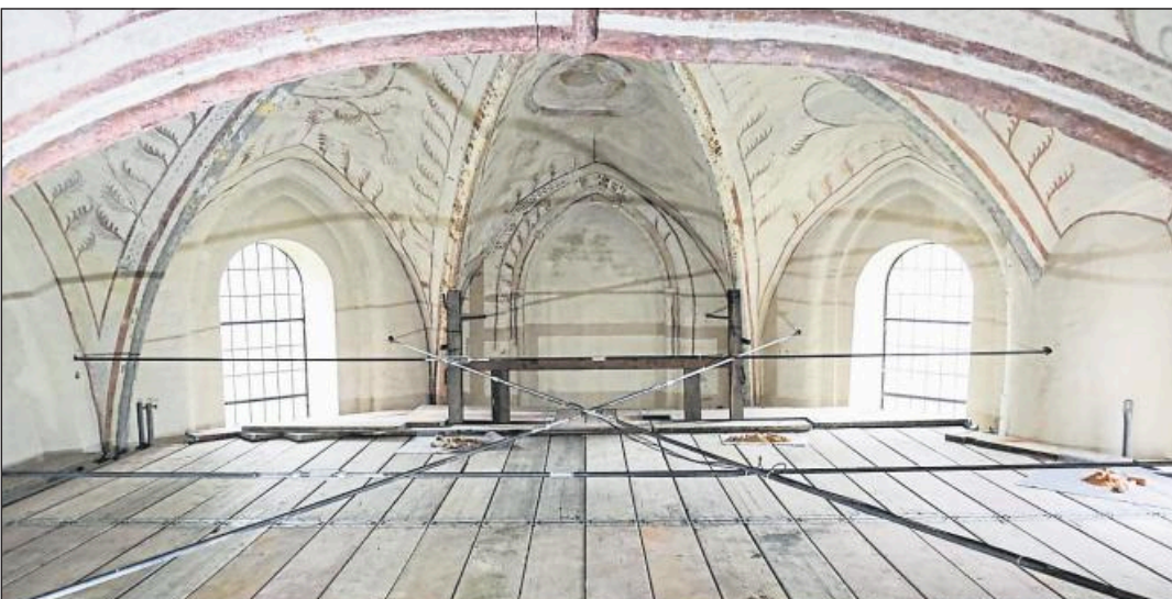
In der St.-Pankratius-Kirche in Oldenswort sichern Streben den Dachstuhl.
